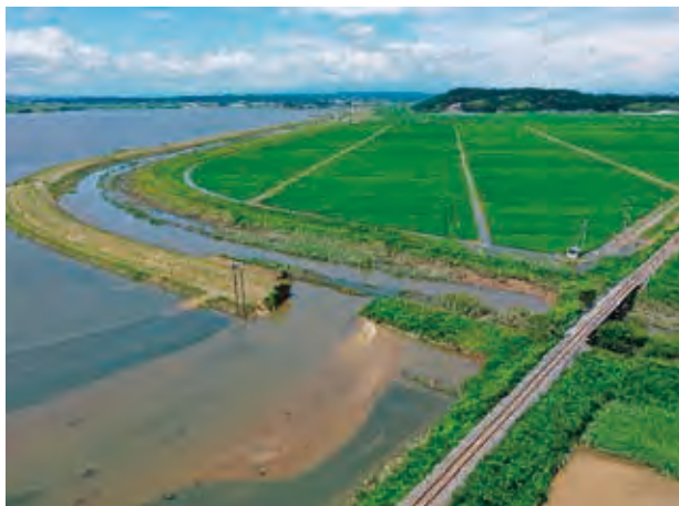
堤防決壊状況 (宮城県美里町)
