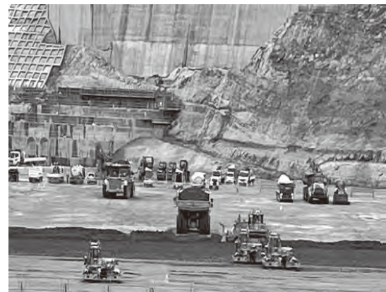
写真-4 クアッドアクセルによるCSG打設状況
