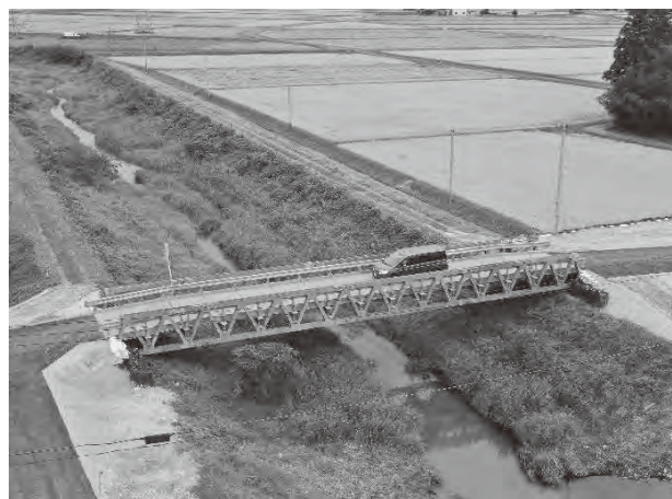
応急組立橋の架設による生活道路の確保
