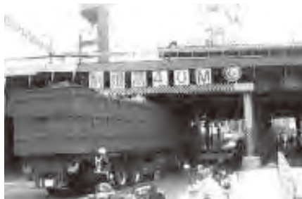
二葉橋ガード 外堀通り
