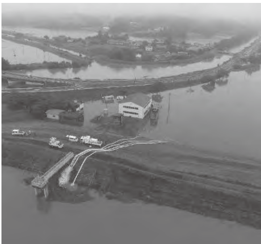
宮城県松島町での内水排除状況
