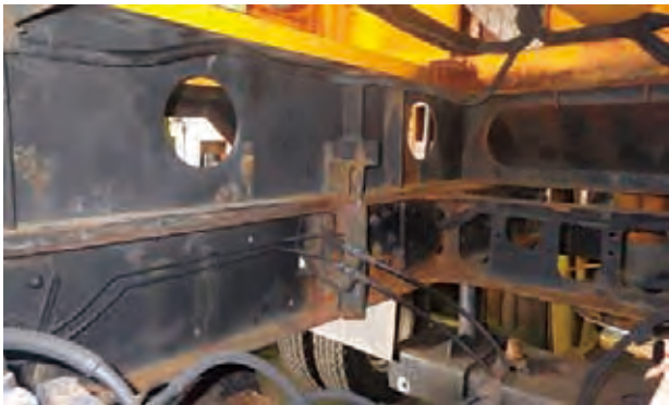
写真-7 途中から試行塗装Aを施工した車両状況1
