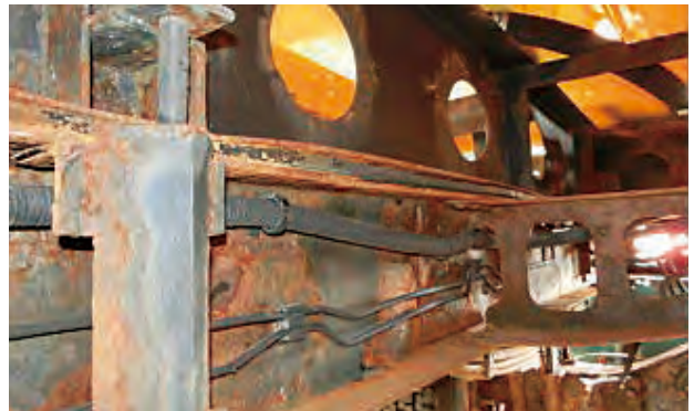
写真-2 エポキシ樹脂塗装 シャシフレーム内側（10年経過）
