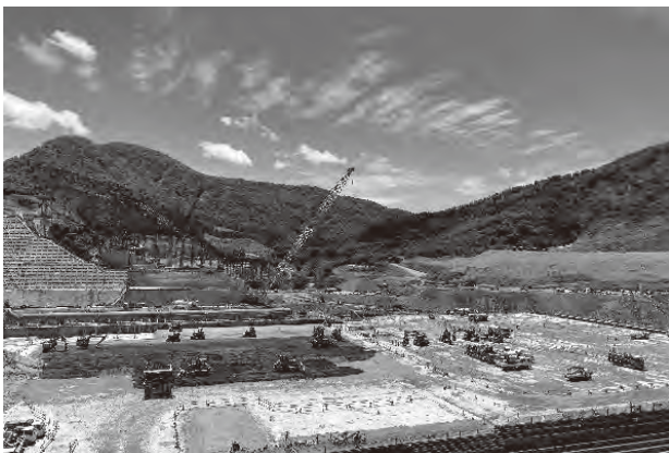
自動化重機による成瀬ダム施工状況 (KAJIMA DX LABO展望デッキより)
