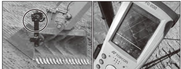
図②バケットの角度は勾配目視装置で確認
