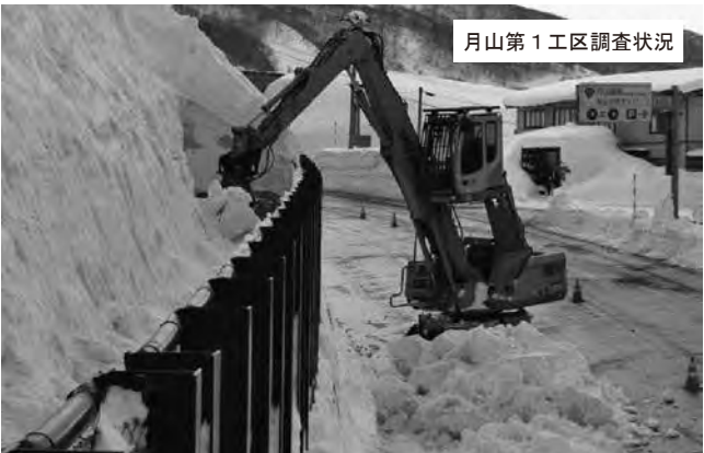
写真5 防護柵背面のポケット造成作業（選定機）
