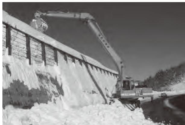
写真1 雪庇除去作業状況
