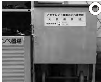
台車保管状況 1
