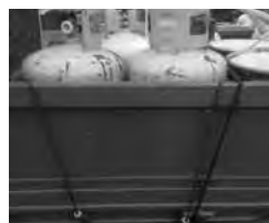
LPガスボンベ固定
