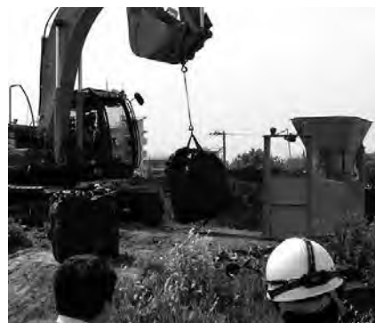
大型土のう吊り出し設置状況
