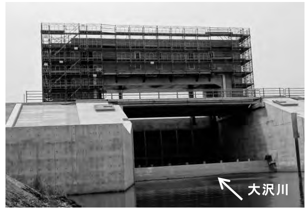
写真－4 概成（月浜第二水門）※上屋施工中
