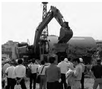
クイックホッパーへの土砂投入状況
