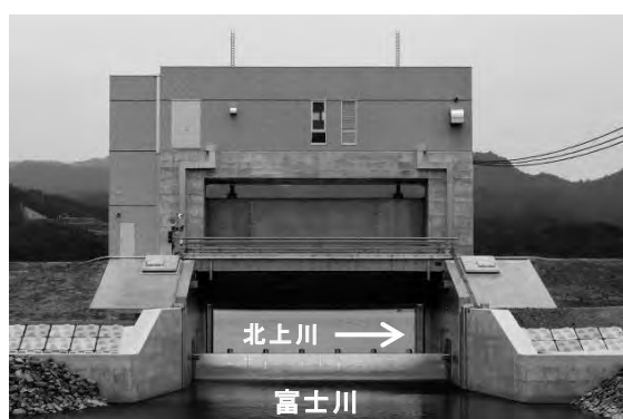
写真－2 完成（釜谷水門）
