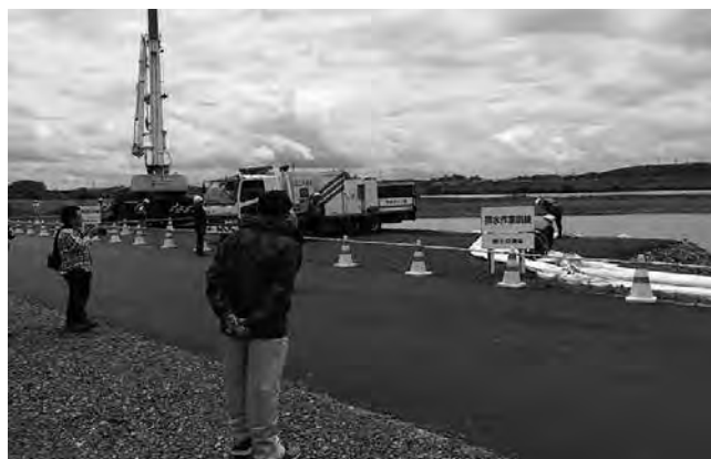
排水ポンプ車による排水作業訓練
