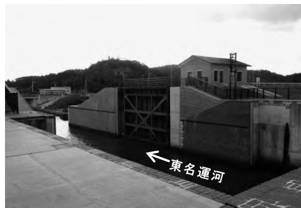
写真－9 完成（野蒜水門）
