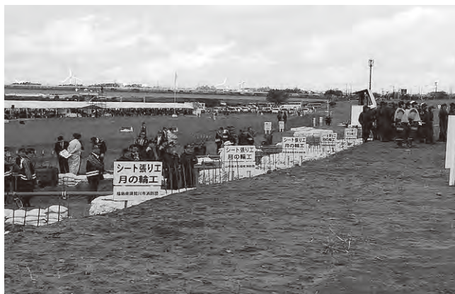
各種水防工法の演習作業
