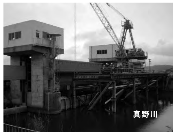
写真－7 仮設の様子（真野川水門）
