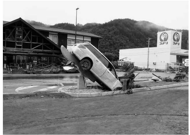
道の駅「いわいずみ」の被害状況
