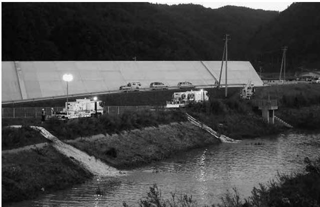
岩手県岩泉町での内水排除状況
