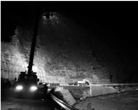
道路啓開での照明作業（岩手県宮古市）
