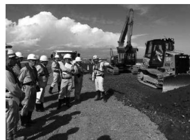
写真－1 CSG敷均し説明状況
