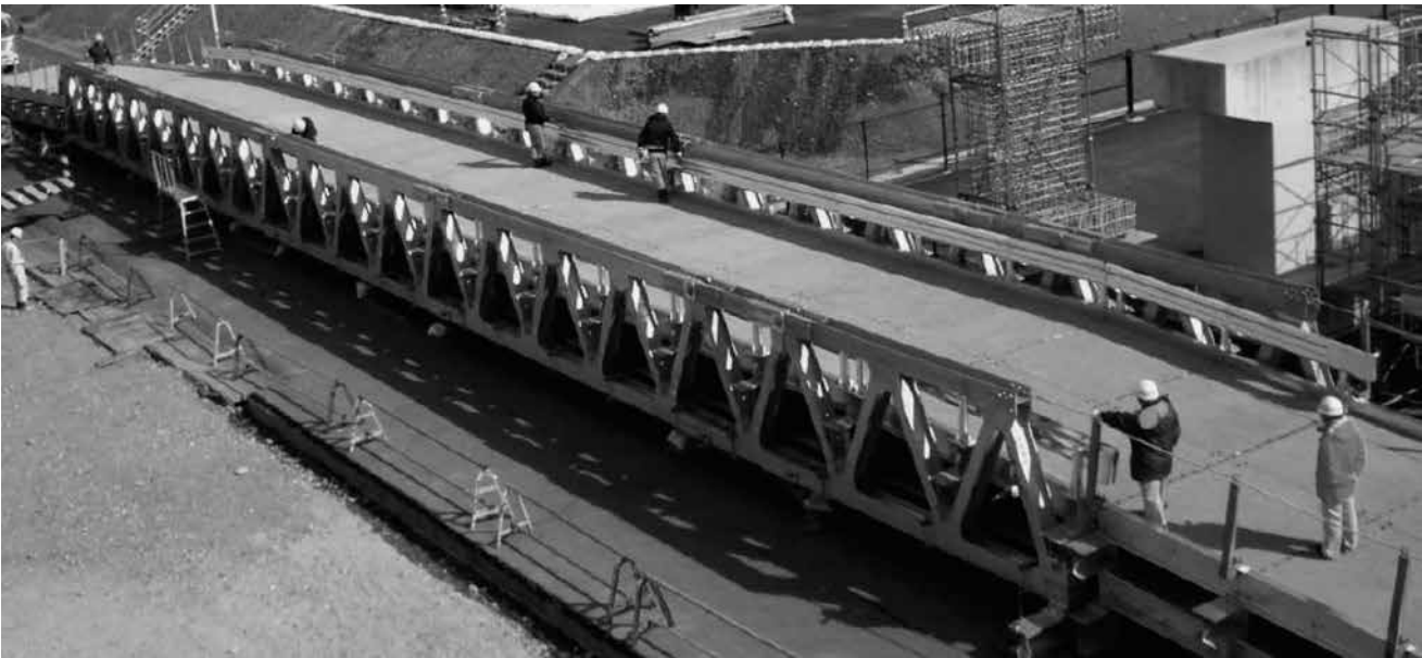
写真－３ 応急組立橋（B-C2401）全景
