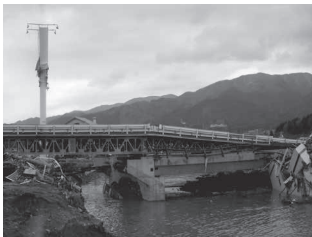
写真－1 北陸地整応急組立橋（川原川橋）
