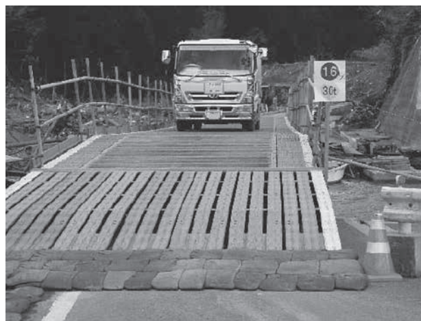
写真－2 陸上自衛隊MGB橋（水尻橋）
