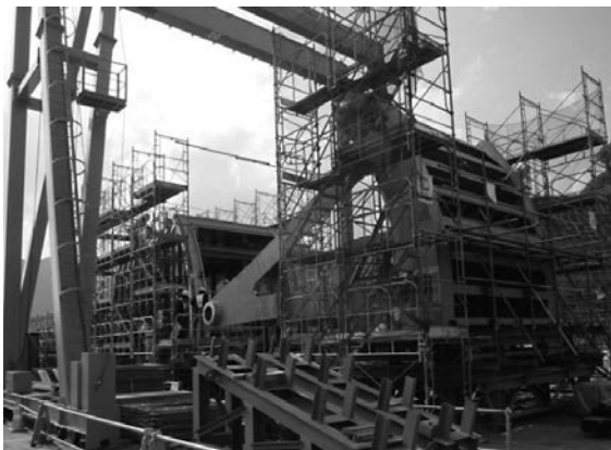
写真3 2013/7/1撮影 組立中の扉体とトランジション管
