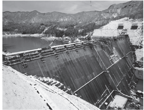
写真1 2013/11/13撮影、工事中の津軽ダム全景 堤体の高さがEL209.0mに達し、上流にある目屋ダム 天端高さEL187.5mを超えています。
