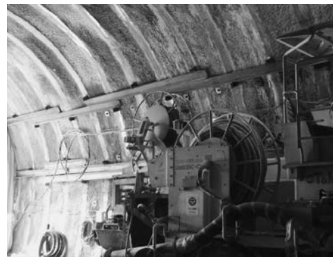
写真－7 坑口部鋼製支保工の補強状況
