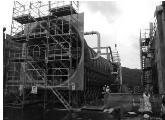
写真6 2013/7/26撮影 堤体上で放流管とトランジション管の接合準備
