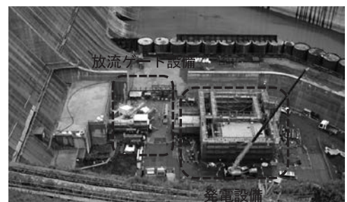
写真7 2013/7/22撮影 放流ゲート設備と別途工事の発電所 全景
