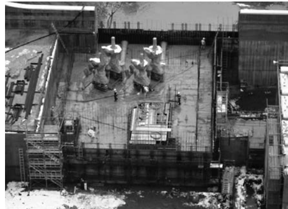
写真11 2013/11/15撮影 コンクリート打設途中、越冬前の状況
