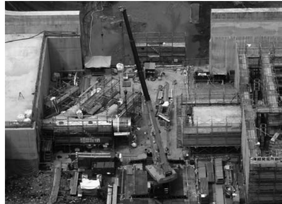
写真9 2013/7/15撮影 放流管、分岐管、据付状況
