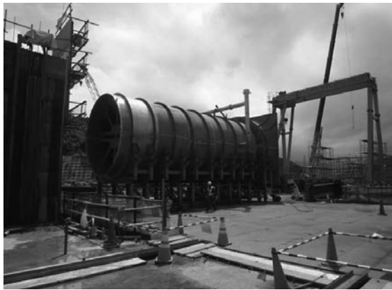
写真5 2013/7/25撮影 作業構台上を移動する放流管（重量は約55t）
