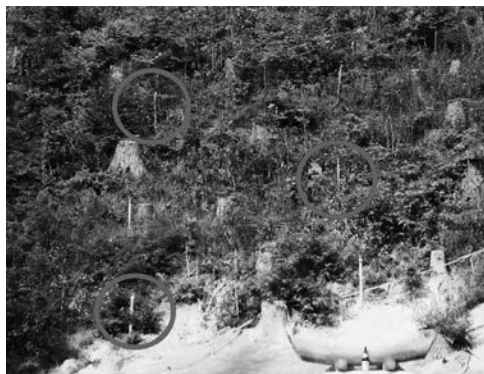
写真－6 坑口部地表面変位計測用のターゲット
