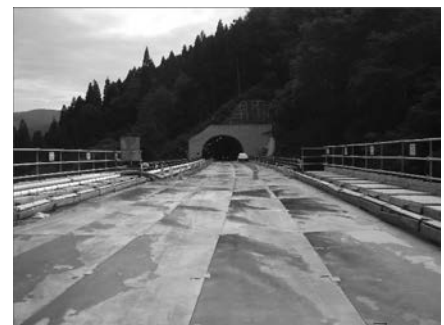
写真-2 第7号橋梁の拡幅状況
