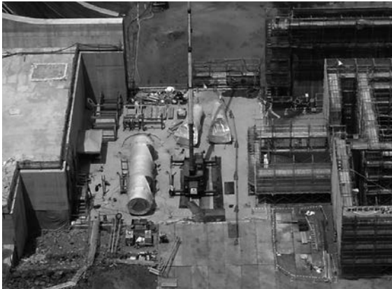
写真8 2013/6/16撮影 放流管、分岐管搬入、仮置き状況
