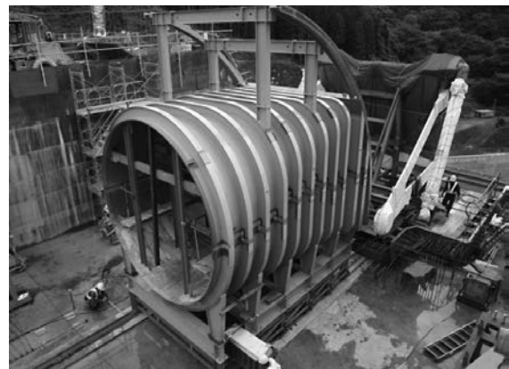
写真4 2013/7/24撮影 堤体に移動した扉体とトランジション管
