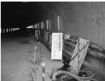
写真－４ コンクリート舗装された作業用通路
