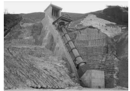
写真3 取水ゲート全景
