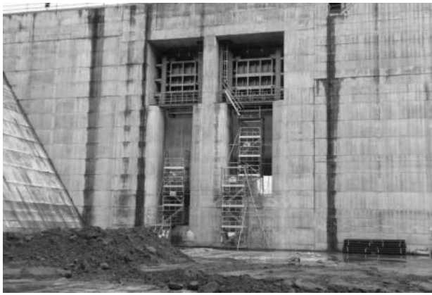
写真10 洪水吐きゲート全景
