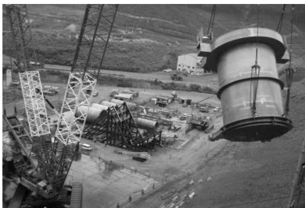
写真4 6段扉吊込み
