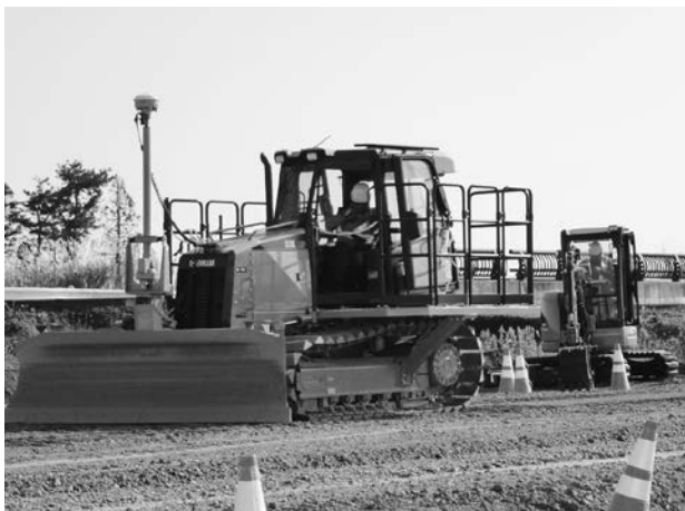
写真－4 講習用ブルドーザ 講習生が同乗して、オペレーティングや、MC（マシンコントロール）の様子を見学体験するよう作られた安全ガード付きブルドーザ。
