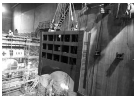
写真15 主ゲート扉体吊込状況
