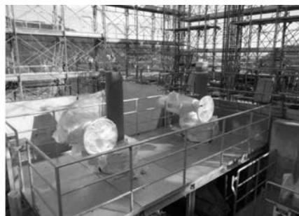
写真20 利水2号ゲート
