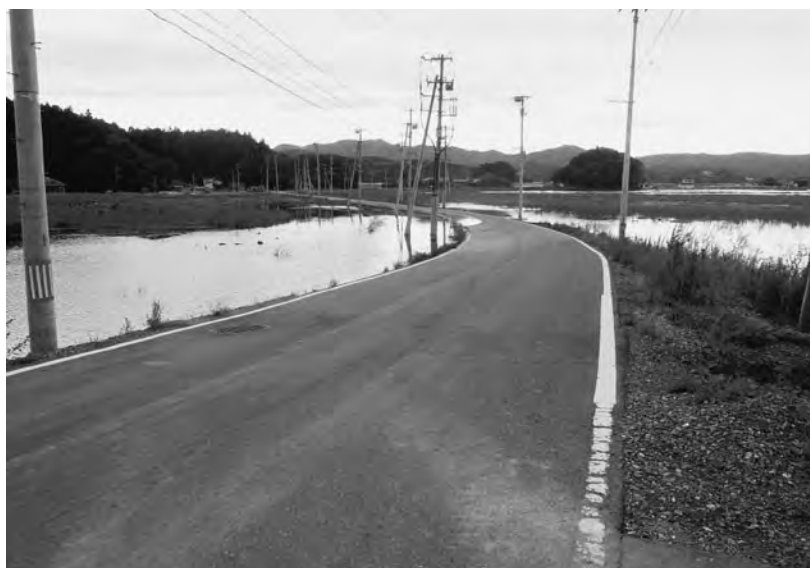
写真－５ 道路冠水排水作業後 (石巻市針岡地区)
