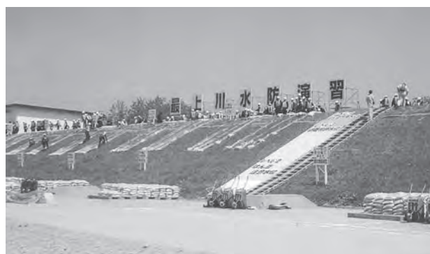
シート張り工訓練
