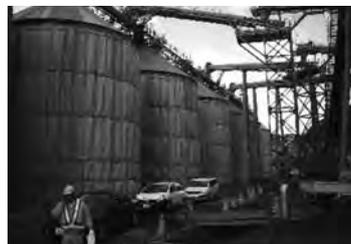
写真－3 骨材貯蔵ビンのシート養生
