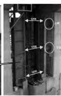
② 開度測定用メッセンジャーワイヤーの損傷
