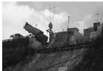
写真－5 固定型ケーブルクレーン
