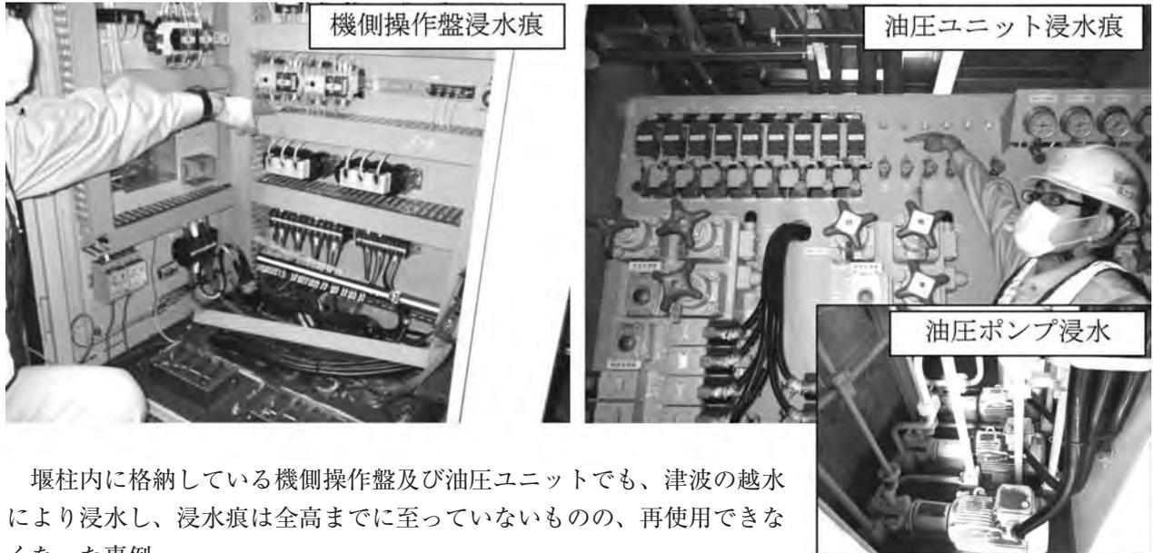
堰柱内に格納している機側操作盤及び油圧ユニットでも、津波の越水により浸水し、浸水痕は全高までに至っていないものの、再使用できなくなった事例。
