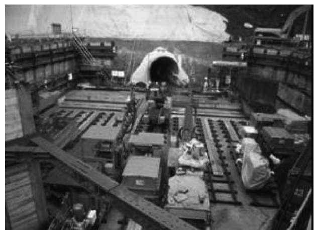
トンネル掘削機械
