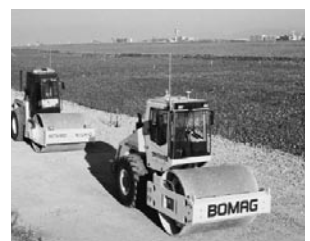
写真-2 振動ローラー
