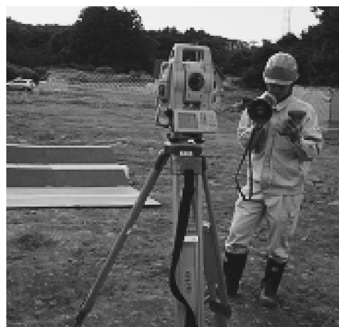
TSによる出来形管理の説明
