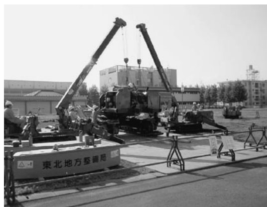
写真-9 分解組立試験の状況(エンジンフレーム組立)
