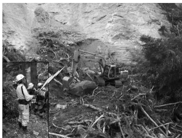
写真－６ 無人化施工作業
