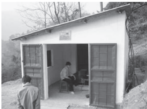
小水力発電所
