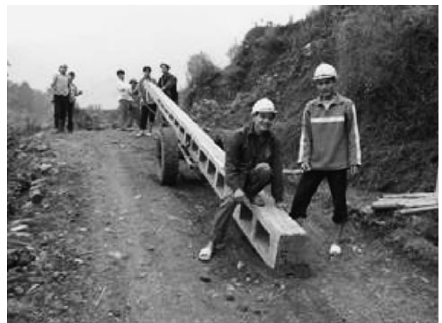
電柱の運搬
