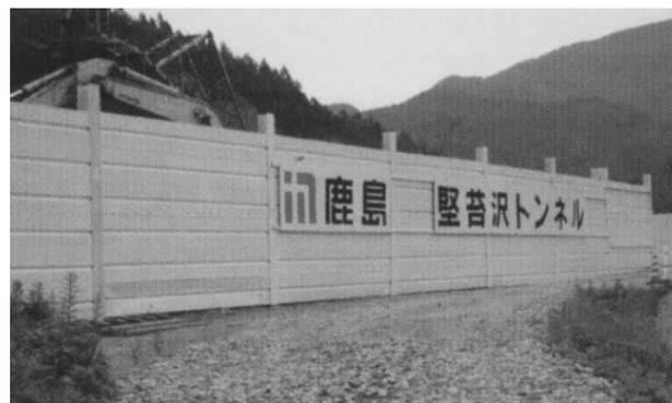
写真-6 ズリ仮置き場周辺の防音壁設置状況
