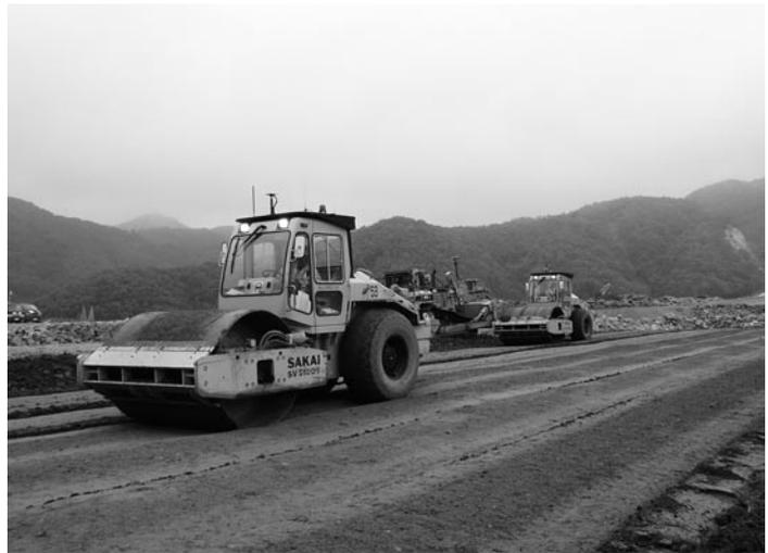
写真1 GPSで位置を確認しながら締め固め
