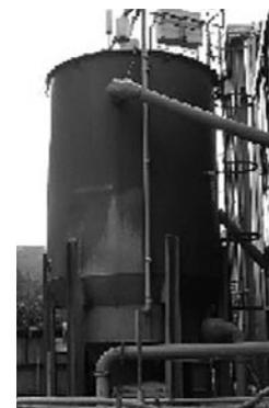
写真-4 砂ろ過装置
