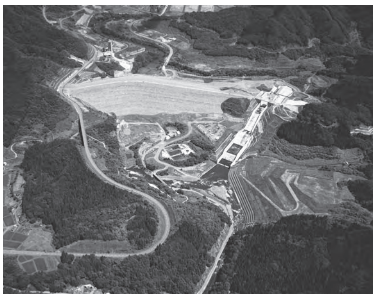
写真－1 森吉山ダム全景（H21.7下流より撮影）
