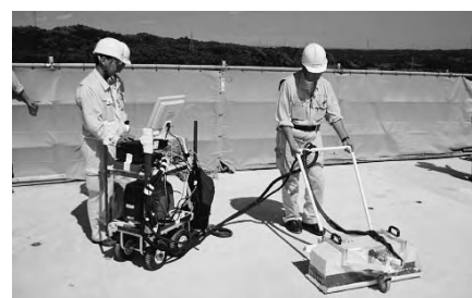
図－2 MPAレーダによる検査状況
