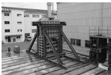
写真-7 主ゲート製作状況
