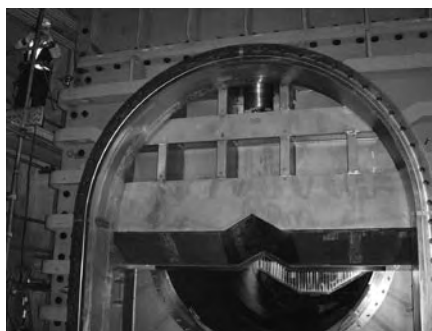
写真-9 主ゲート据付状況
