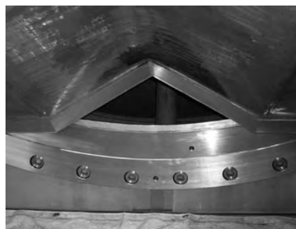
写真-10 主ゲート底部120°切り欠き部位
