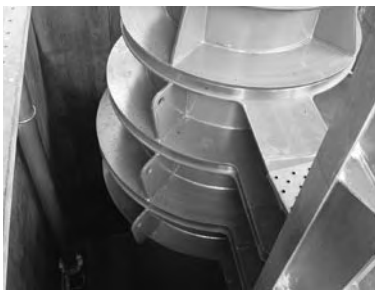
写真-4 1号多段ゲート製作状況
