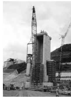
写真-3 2号ゲート吊り込み状況
