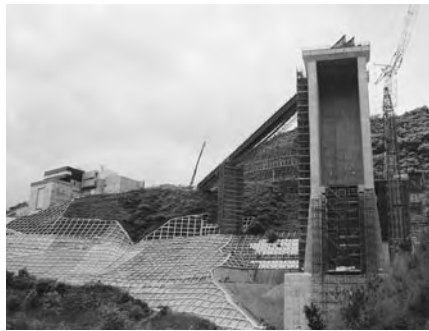
写真-2 管理所（左）と取水塔（貯水池内より）
