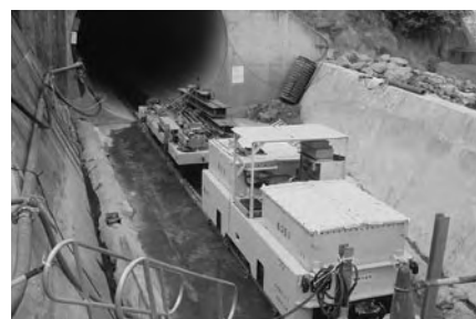
写真-8 バルブ搬入用8t電車と台車
