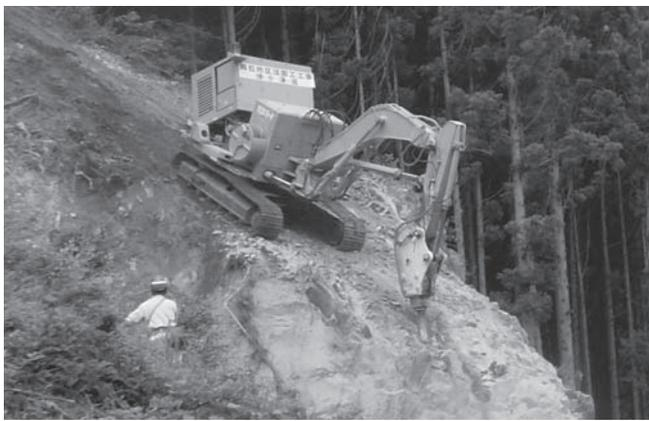
高所岩盤掘機による岩盤掘削状況
