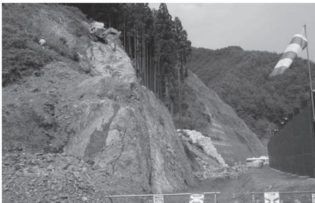
岩盤掘削現場 右側の壁が落石防護柵
