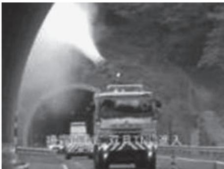
キャビテーション清掃装置によるトンネル照明灯具清掃 50km/h
