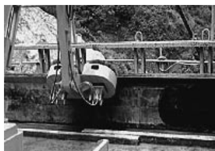
(写真2) ブラシ2個型 型枠テーパ面清掃時
