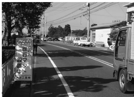
【松山河川国道事務所管内での使用状況（一般国道11号）】
