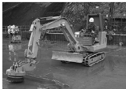
(写真1) ブラシ1個型 グリーンカット作業時
