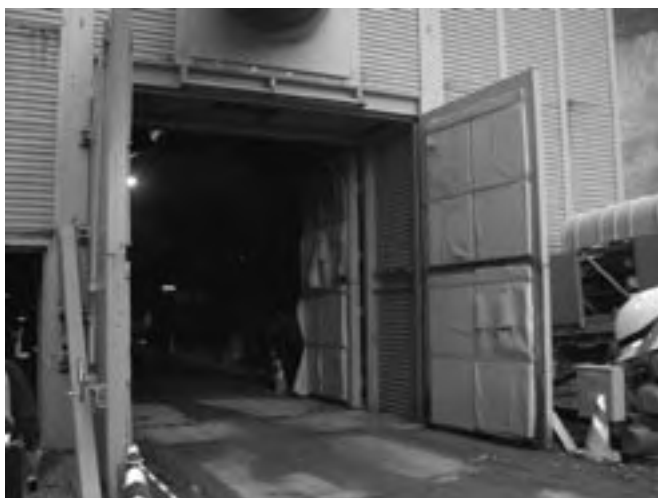
坑口の防音扉（内外への両開き）
