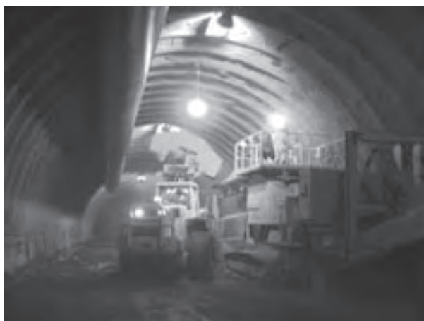
坑内 発破ズリクラッシャー投入状況 (サイドダンプローダ使用)
