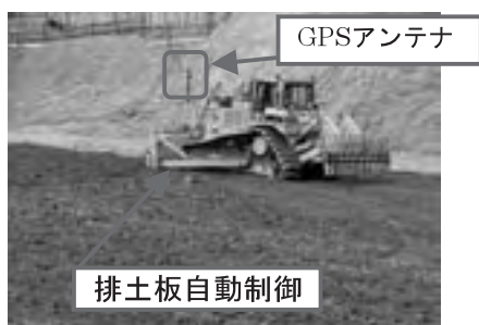
写真-2 3D-MCブルドーザー
