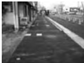
写真3 歩道での設置状況
