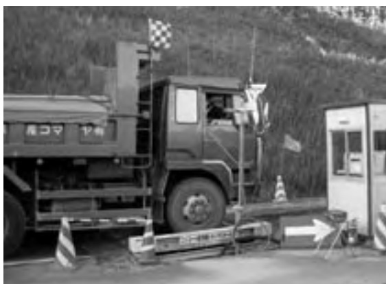
トラックスケール設備
