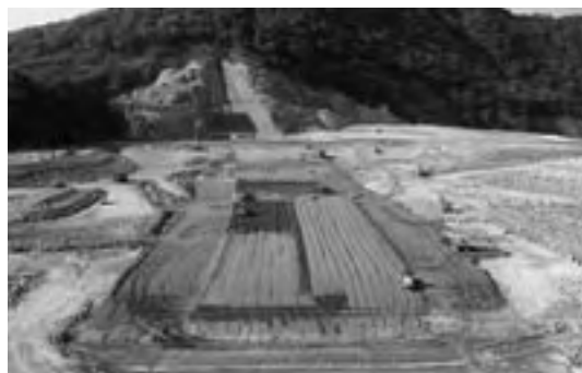
写真-1 堤体右岸側全景
