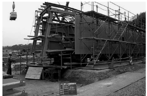
ベルコンフレームの組立（仮組ヤード）
