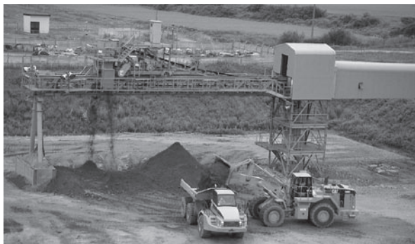
ストックヤードでの積み込み運搬
