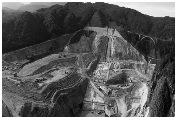
右岸堤頂を望む
