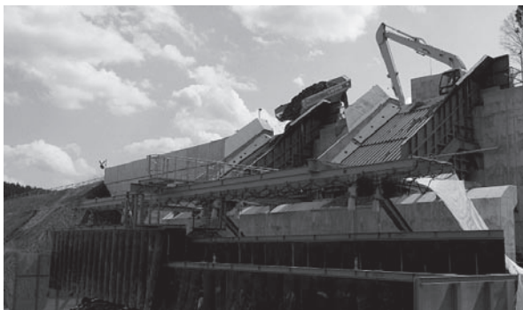
コア材の掻き落とし作業
