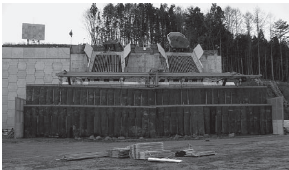
安全施設（オーバーサイズ材の処理）
