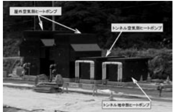
写真-1 各熱源用ヒートポンプ設置状況
