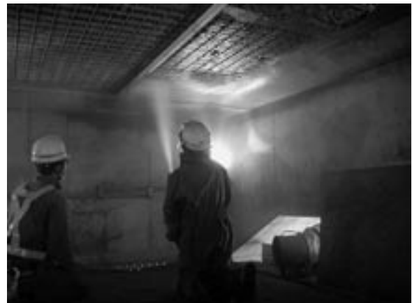
乾式吹付け状況
