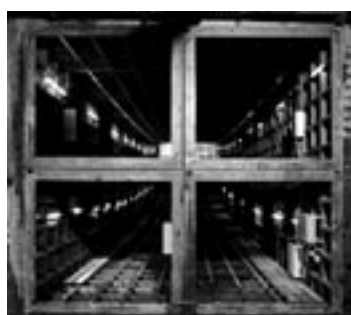
図2 掘削完了状況
