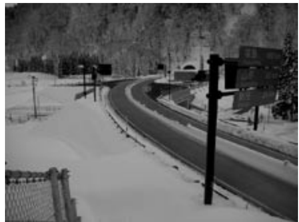
写真-2 消融雪設備による本線の融雪状況 (秋田側坑口) H17.12.19撮影
