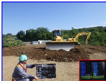
【3DMCブルドーザーによる敷均し】
