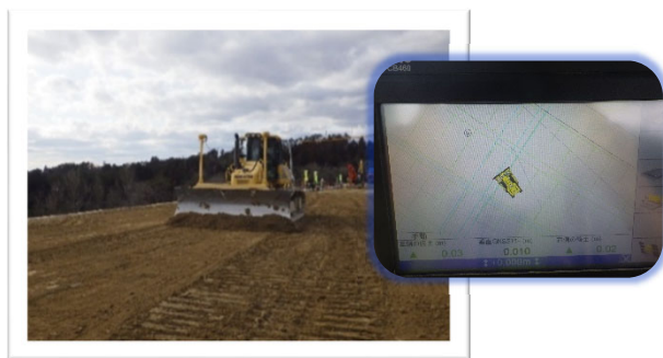
【MCブルドーザによる路体盛土の敷均し】
