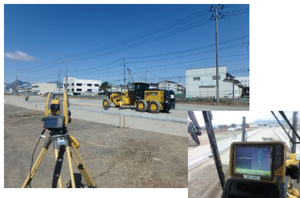
MCモーターグレーダによる敷き均し
