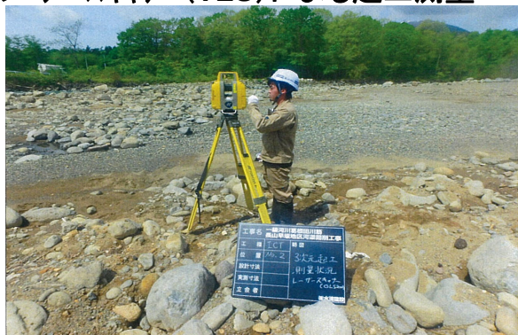
レーザー scanner (TLS) による起工測量
