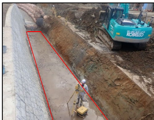
TLSによる3D出来形測量
