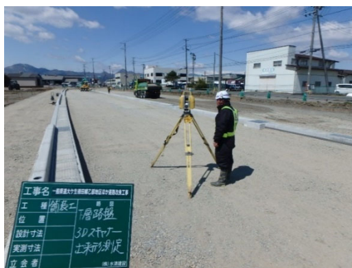
TLSによる出来形管理
