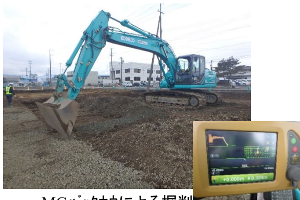
MGバックホウによる掘削
