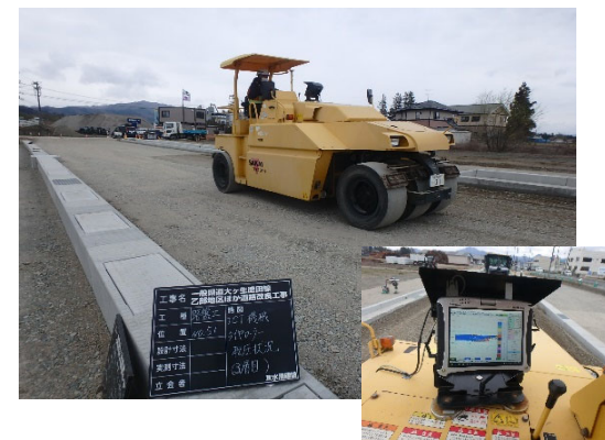
MCタイヤローラによる転圧管理
