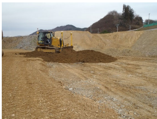
ICTブルドーザーによる整地
