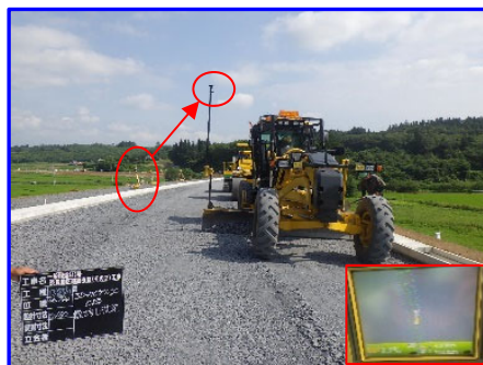
【3DMCグレーダーによる敷均し】
