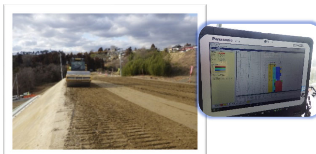
【GNSSローラー締固め管理】
