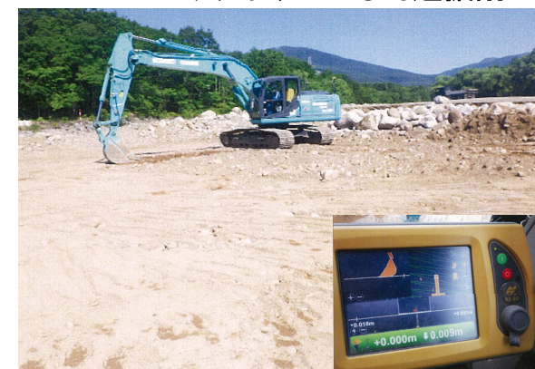
3DMGバックホウによる河道掘削
